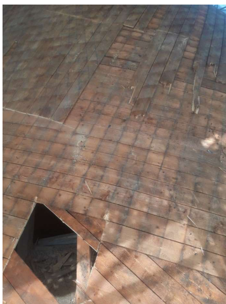
Les couches de volige croisées après dépose des ardoises
