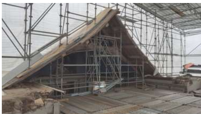
Détail de l'étaie de la charpente du chœur
