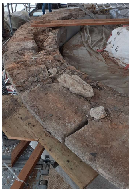
Détail des pierres de corniches de l'arrondi Sud du transept
