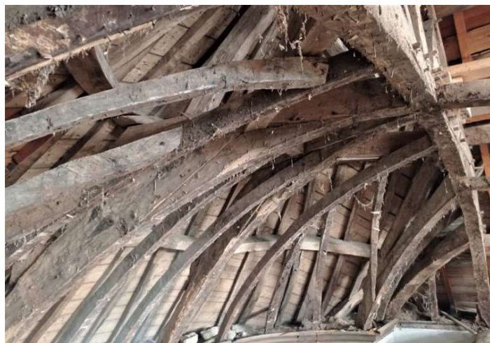
L'arrondi de la charpente et sa volige côté Nord
