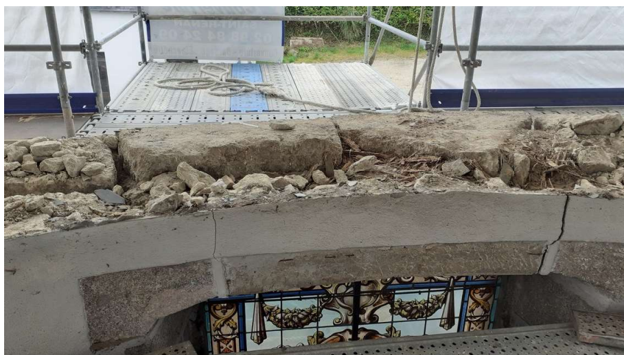
Détail de l'état des arases de murs côté Sud : fissures, désolidarisation des pierres de corniches au dessus du vitrail de Saint-Maudez
