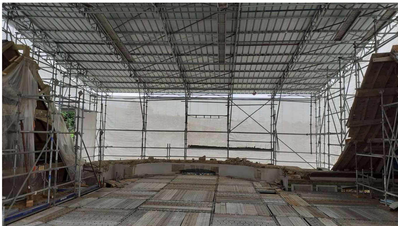
Sous le parapluie de protection, le transept sans sa charpente, avec son plancher métallique. A gauche, la nouvelle charpente de la nef protégée des poussières du chantier ; à droite, la charpente déformée au-dessus du chœur.
