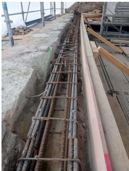
Le ferrailage de la future poutre
