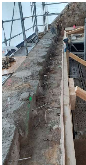
Les pierres de corniche repositionnées
