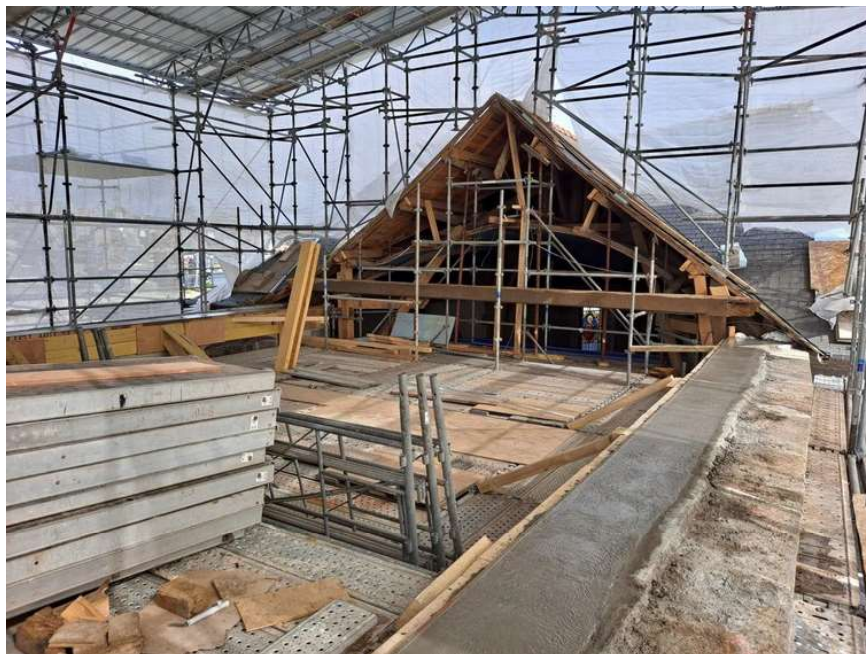
Photo Candio - Vue d'ensemble au-dessus de la nef après coulage du béton
