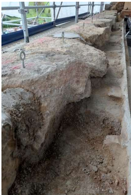
Les pierres de corniche repositionnées
