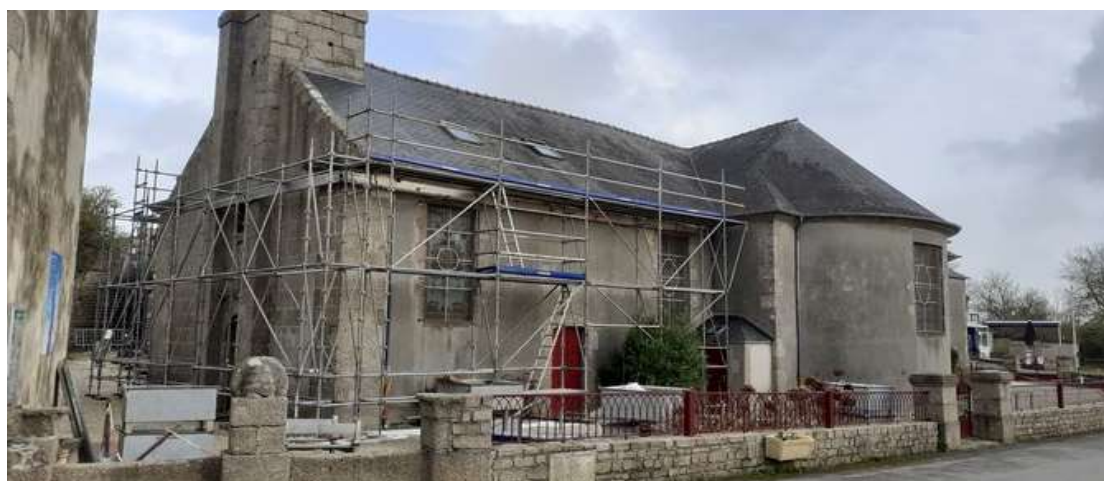
Les échafaudages extérieurs fin décembre
