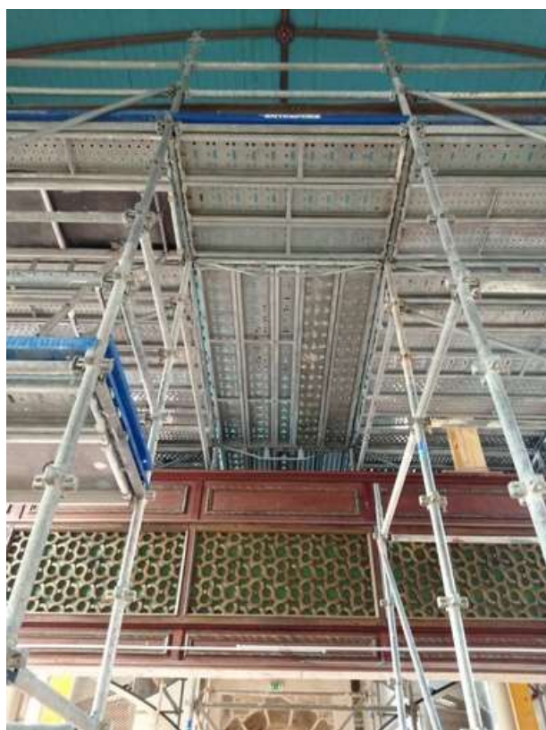
L'échafaudage au dessus de la tribune
