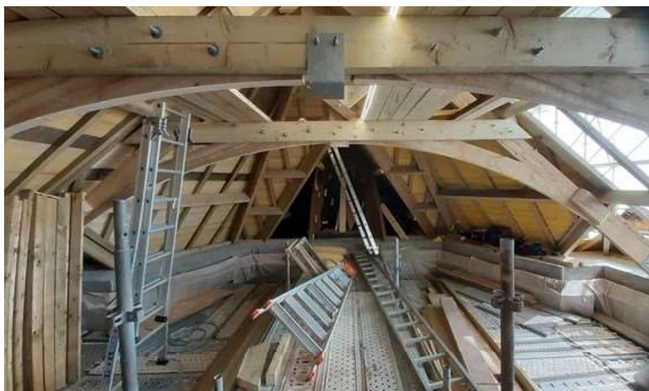
Côté nord, avec le feutre cartonné sur la volige
