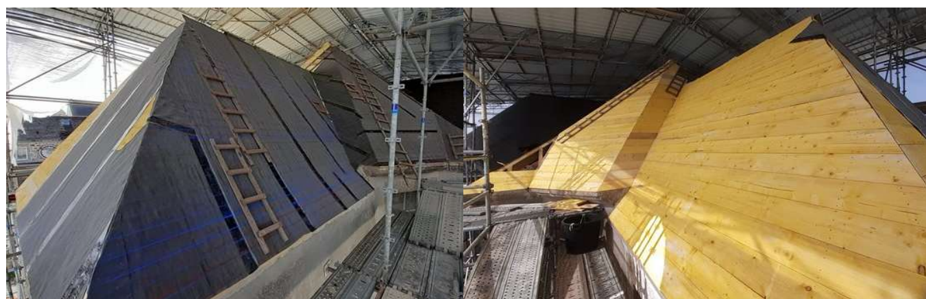
Côté nord, avec le feutre cartonné sur la volige
