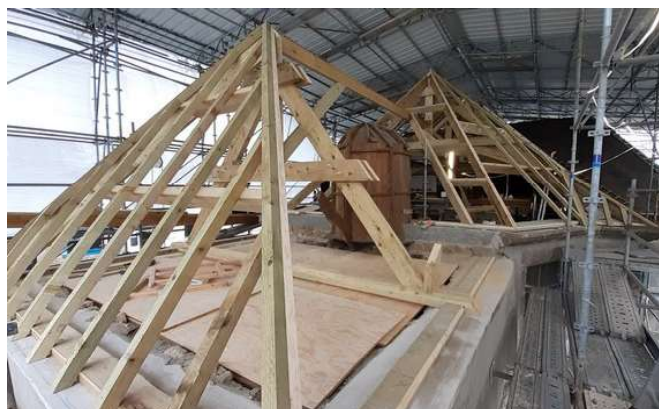
Avancée de la pose de la charpente de la sacristie
