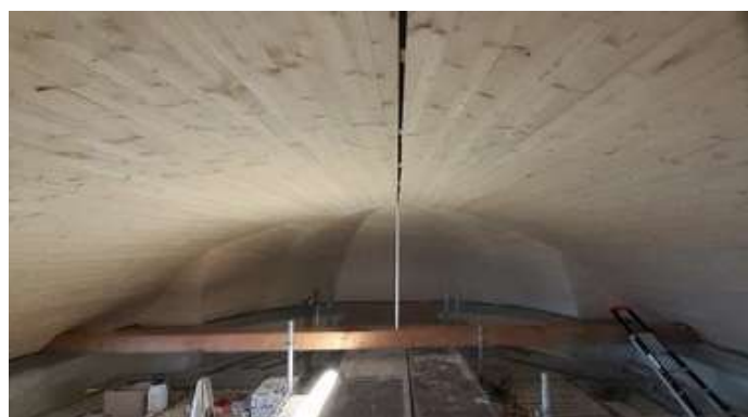
La pose du lambris achevée dans la croupe sud du transept (ici en bois brut avant mise en teinte)
