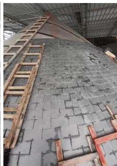
Les couvreurs terminent la pose des ardoises sur la croupe nord et ont démarré au sud
