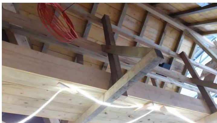
Le chemin de visite dans les combles et les câbles électriques
