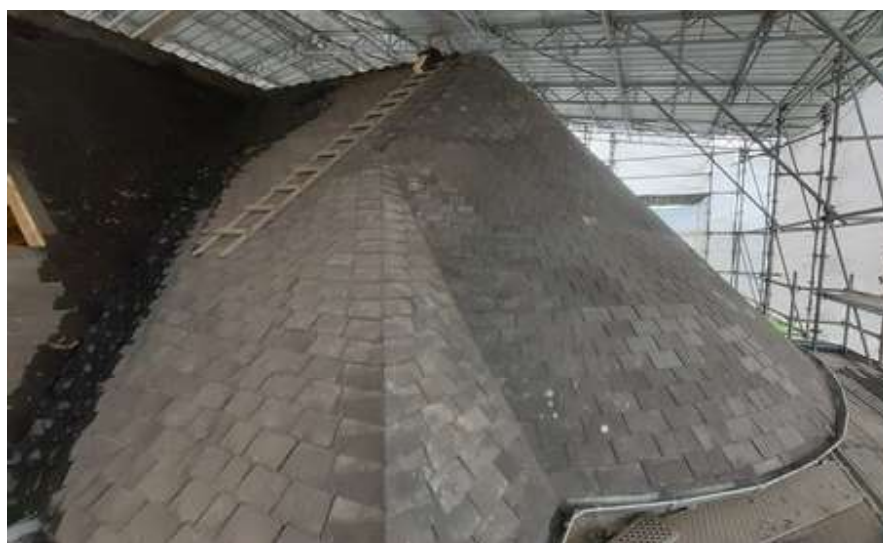
Les couvreurs terminent la pose des ardoises sur la croupe nord et ont démarré au sud
