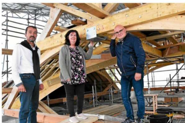
D'abord impressionnés par l'ampleur de l'investissement pour une commune de 2 000 habitants, David Briant (maire), Armelle Jaouen (adjointe à la communication) et Hervé Bothorel (adjoint aux travaux) ont porté le vaste chantier de restauration de l'église de Saint-Pabu, par la grâce d'une fructueuse campagne de souscription privée. Photo Le Télégramme/Yann Le Gall
