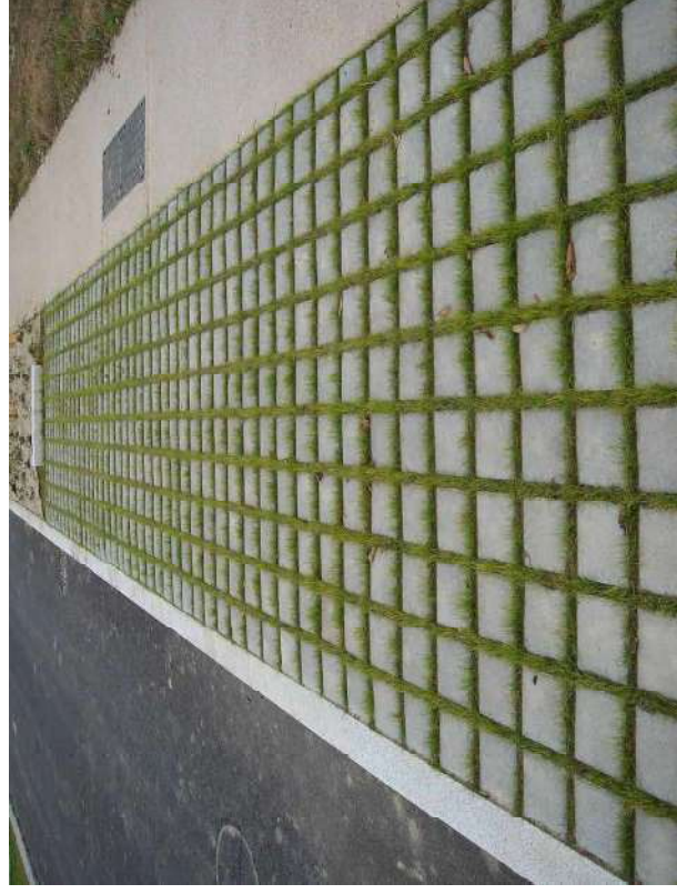
Pavés béton joints en gazon
