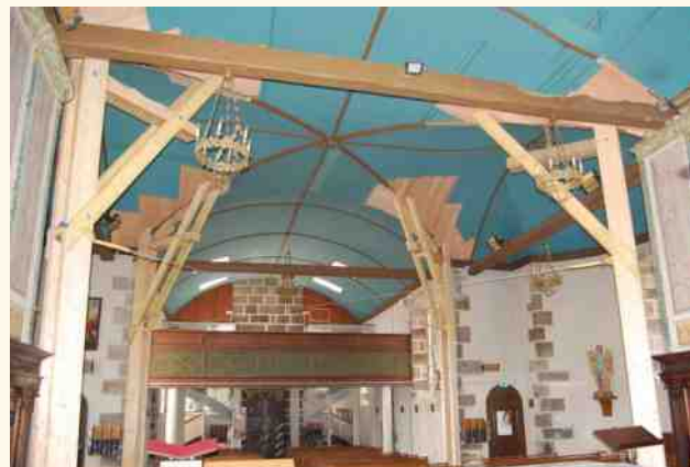
Piliers de soutien de la charpente et du plafond
