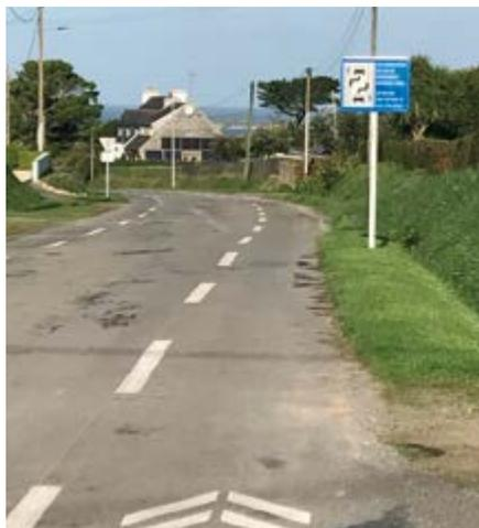
Le Chaussidou de la rue de Korn ar Gazel a été réalisé en juillet. Il permet de visualiser les cheminements réservés à chaque utilisateur et sécurise le partage de la route entre voitures, vélos et piétons. Il fait également partie du projet, plus vaste, de permettre aux habitants de Plouguin (et alentour) de venir fouler nos belles plages de sable fin par un itinéraire entièrement cyclable (voie verte à venir entre le bourg de Plouguin et le rond-point de Sant Ibilio).
