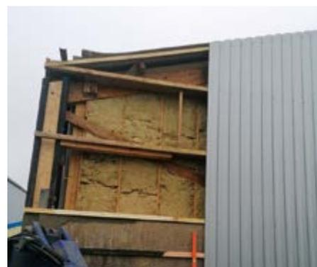
Durant la tempête Ciaran, des salles ont subi des dégâts extérieurs. Un an plus tard, éléments de charpente et toiture, bardages, gouttières sont en cours de remplacement.
