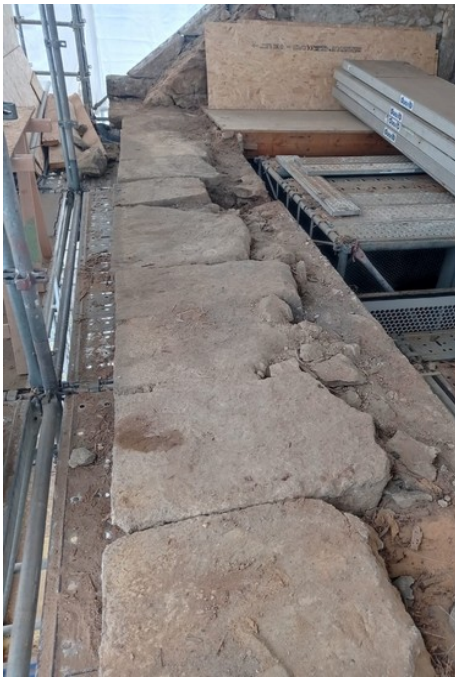
Le mur sud de la nef avant travaux
