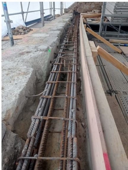
Le ferrailage de la future poutre
