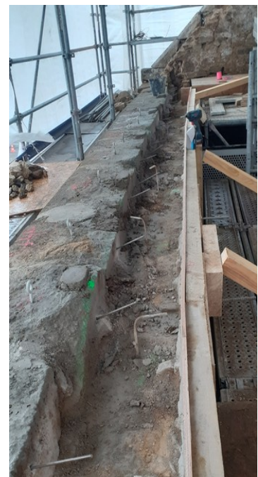
Le filetage des pierres de corniche
