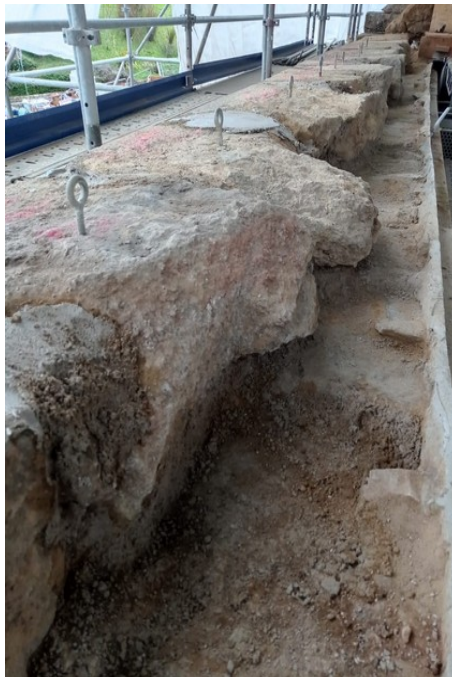
Les pierres de corniche repositionnées
