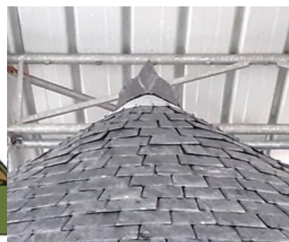
La signature en zinc réalisée et posée par les couvreurs sur le transept
