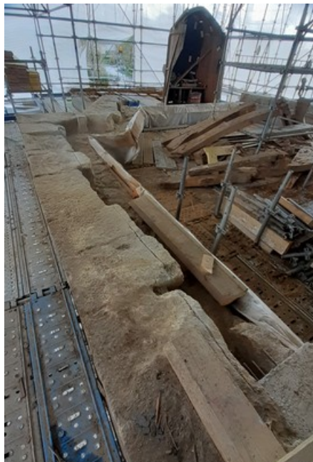
Les pierres de corniche marquées avant découpe côté nord
