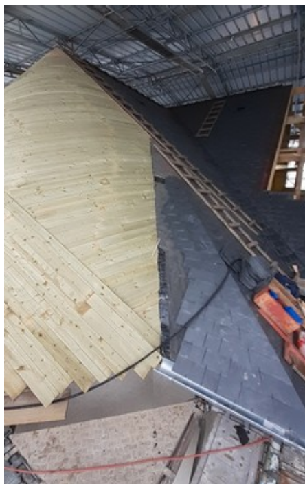
Pose de la volige en double couche croisée sur la croupe sud
