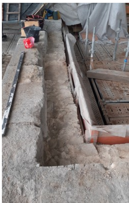
Les pierres de corniche découpées sur le mur sud
