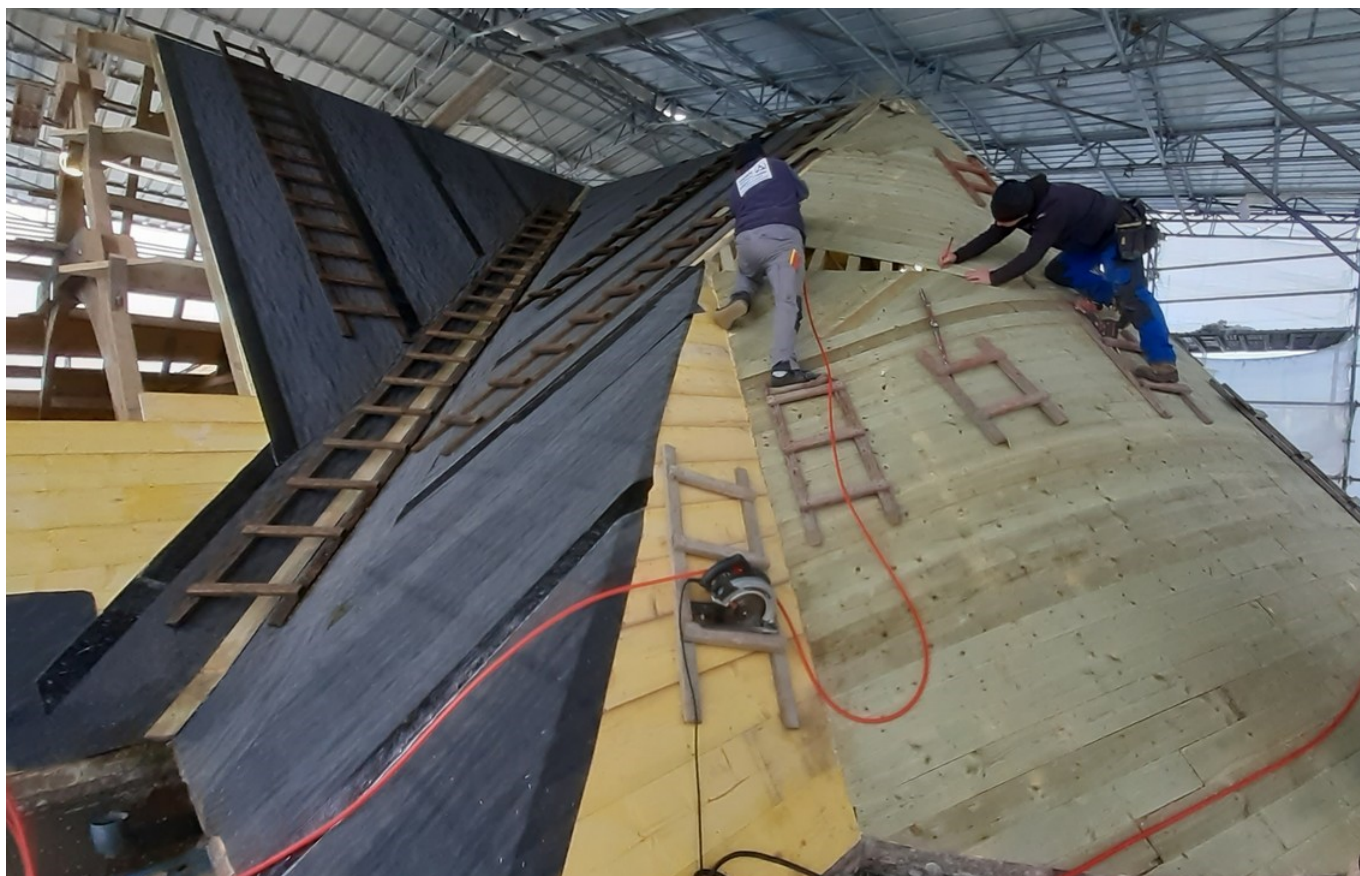
Les couvreurs en pleine pose de la volige croisée côté Nord Est de l'arrondi
