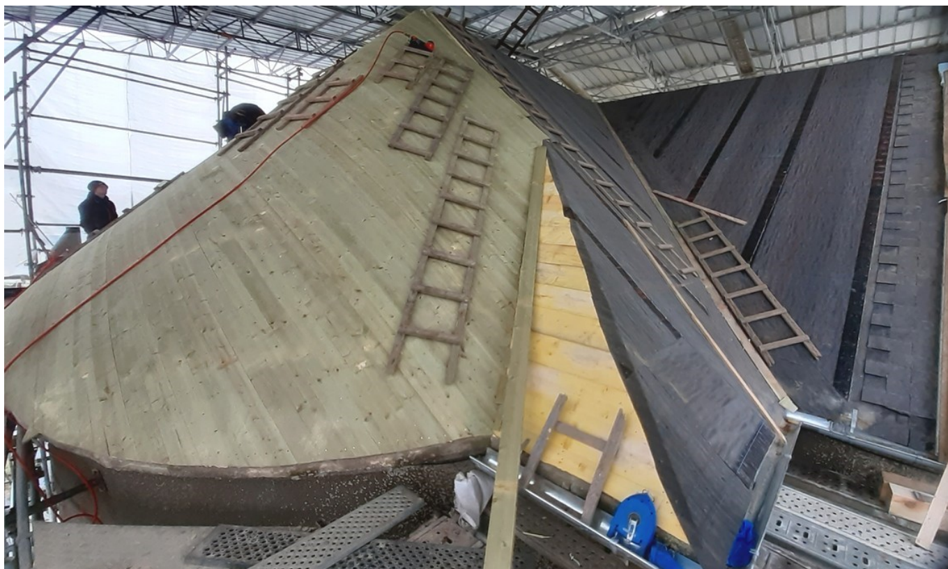
Vue de l'arrondi côté Nord Ouest
