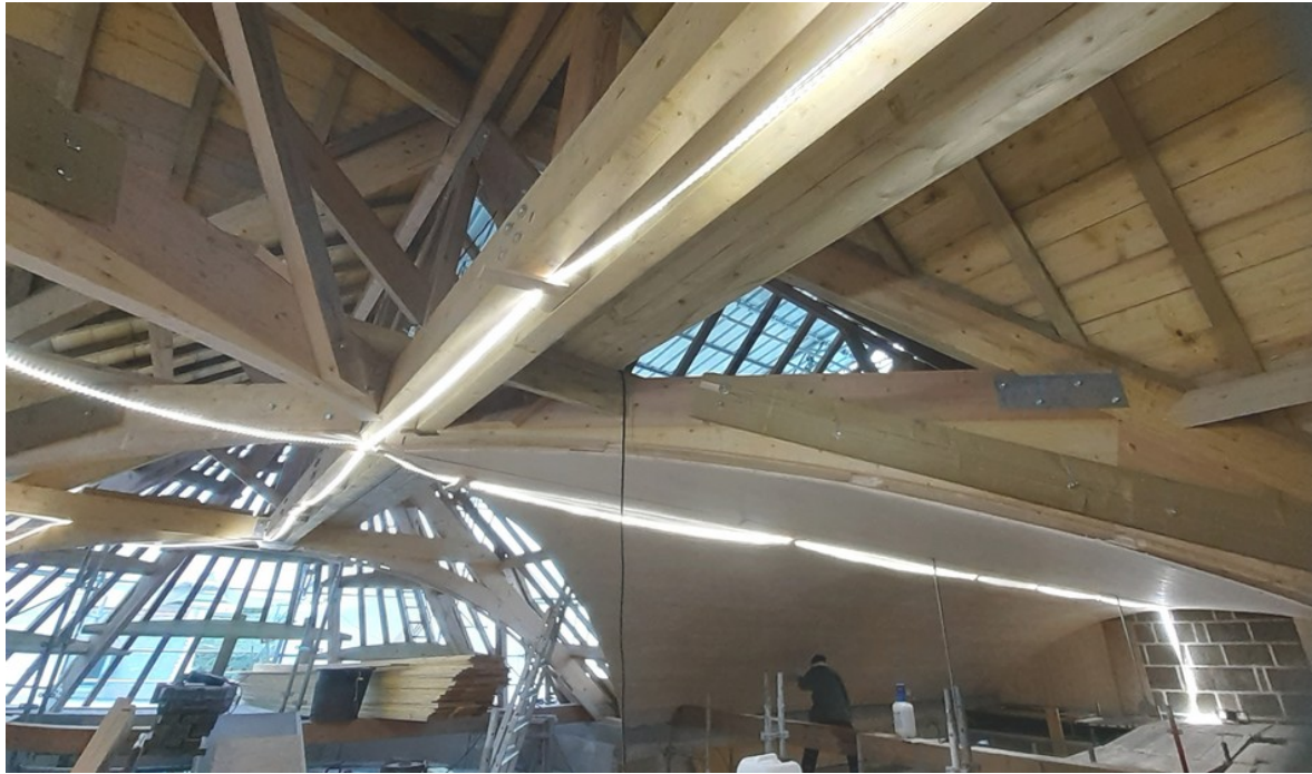
Une autre vue de la charpente du transept et la partie voûte posée.
