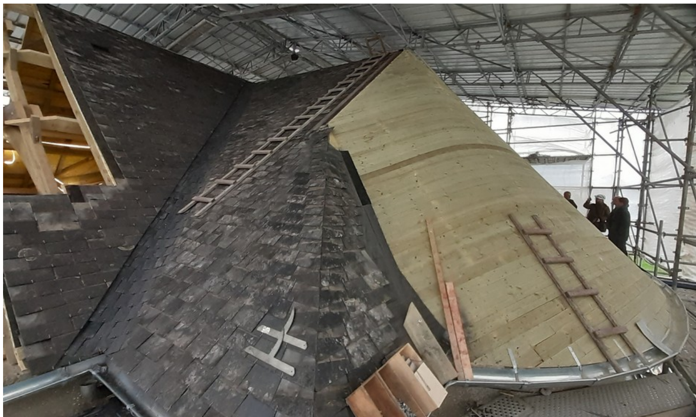
L'avancement de la pose des ardoises côté Nord Est.
