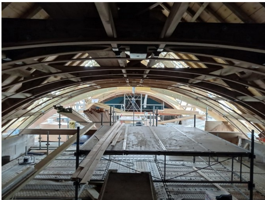
Vue des cerces dans la nef : le lambris de la voûte sera fixé sur ces arrondis
