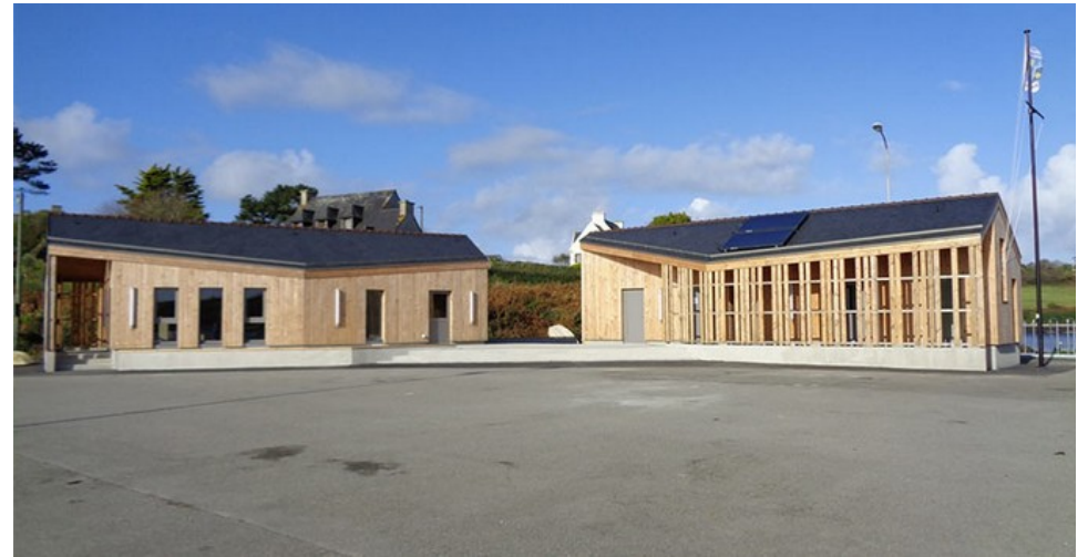
Le pôle nautique construit en 2019
