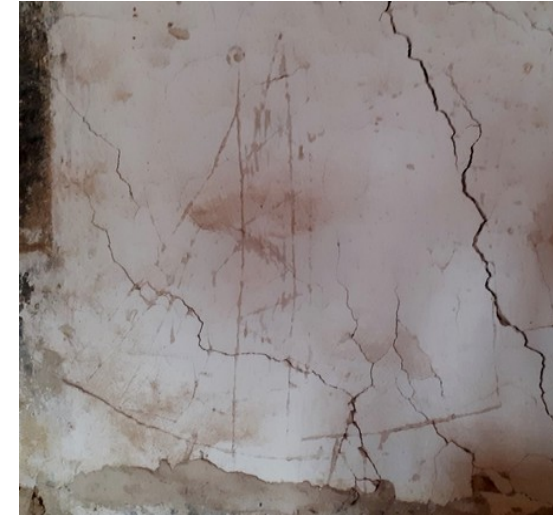
L'ex-voto découvert durant les travaux de restauration de l'église, dessiné sur le mur de chaux du grenier de la sacristie
